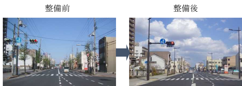
【写真 和歌山野上線（和歌山市田中町）】
