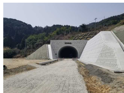
【写真上：別所橋から有田川町方面を望む（海南市別所）】
