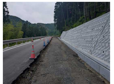
【写真 国道424号（海南市上谷）】
