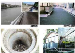
雨水貯留浸透施設の実例
