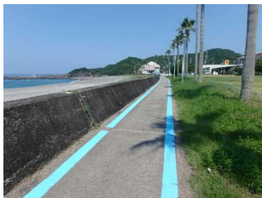
白浜日置川自転車道線(白浜町)
