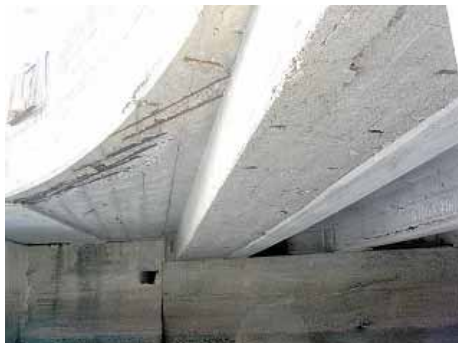
県道有田港線 天浦橋
