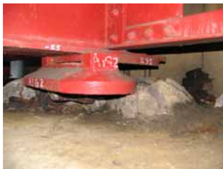
県道垣内貴志川線 愛宕橋
