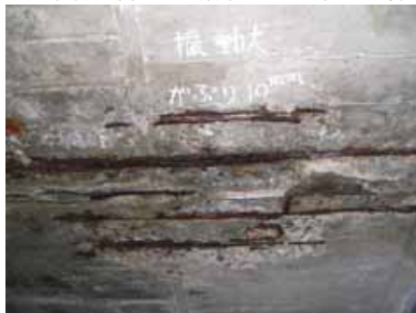
一般国道370号 五反田橋
