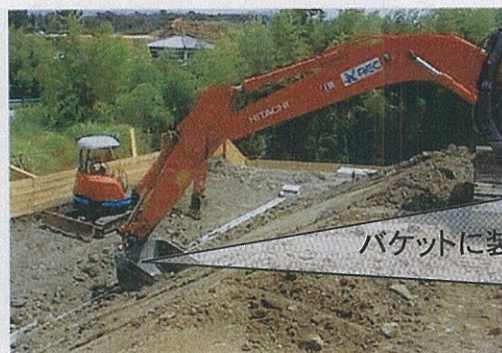
機械(盛土)法面仕上り
