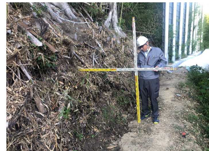
落下高さ1.2m
