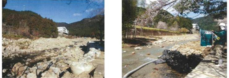
当該工事は台風12号で発生した土石流により堆積した河川内の土砂除去工事であり、堆積土の中に混入するコンクリート殻や流木等の分別処分を徹底し、迅速に工事を完成させた。
