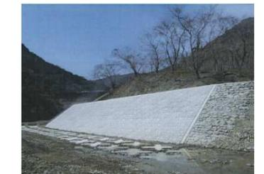
当該工事は台風12号の出水により被災した河川護岸復旧工事であり、隣接工事が完了するまで1カ月間施工できないなど制約があるにも関わらず、工程管理を的確に行い、迅速に工事を完成させた。
