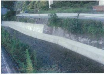
当該工事は台風12号の出水により護岸基礎部が洗掘されたため、根継工及びブロック積工を行う工事であり、基礎部掘削に伴い、既設護岸の挙動確認を行うなど安全に工事を進めた。
