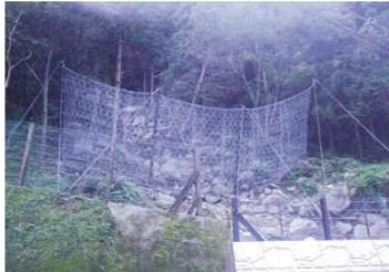
当該工事は台風12号の豪雨によりがけ崩れが発生し、通行の安全を確保するため落石防護柵の復旧を行う工事であり、隣接工区との調整を図り、安全に工事を完成させた。また、隣接箇所に植生工を行うなど企業努力がなされていた。
