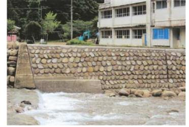
当該工事は台風12号の出水により被災した河川護岸復旧工事であり、関係者に工事説明を行うなど積極的に地元調整を行い、迅速に工事を完成させた。また、護岸完成後、護岸の基礎部に巨石を並べるなど工夫した。
