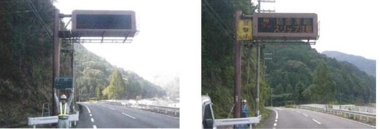
当該工事は台風12号の出水により浸水した道路情報表示板3基の復旧工事であり、NTTや交通規制に伴う関係機関との調整を円滑に行い、迅速に工事を完成させた。
