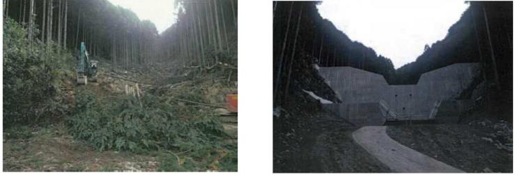
当該工事は台風12号の豪雨により土砂崩れが発生したため、砂防施設を建設する工事であり、規模が大きく工期的にも厳しいものであったが工程管理を徹底し、迅速に工事を完成させた。
