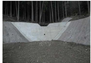
当該現場は、溪床勾配は急で作業範囲も狭く、悪条件の現場であったが、迅速に工事を完成させた。また、谷止工の側壁部や流路部において、現地で発生した石材を利用する等、工夫を行い工事の出来映えが良かった。
