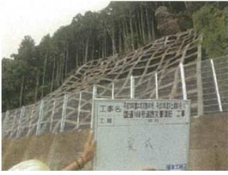
当該工事は台風12号の豪雨によりがけ崩れが発生し、通行の安全を確保するため法面保護を行う工事であった。工事に際し、支障となる立木を調査し地権者と調整を図るなど地元調整に優れ、また、安全に工事を進めた。
