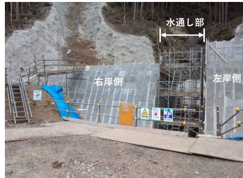
架設通路設置（本堤作業部）
