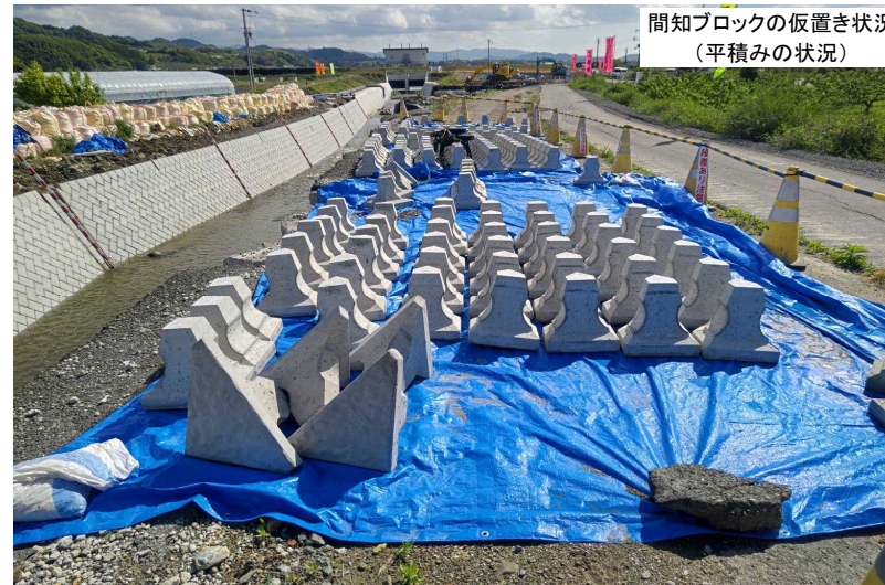
間知ブロックの仮置き状況 (平積みの状況)
