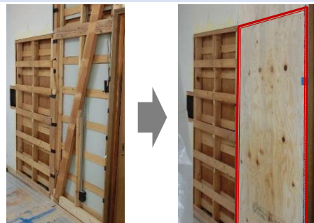
住宅耐震化（構造用合板の設置）
