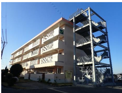
公営住宅に津波避難階段を設置
