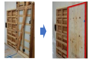
耐震補強（耐力壁の設置）
