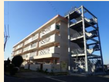
避難階段の増設（県営住宅）
