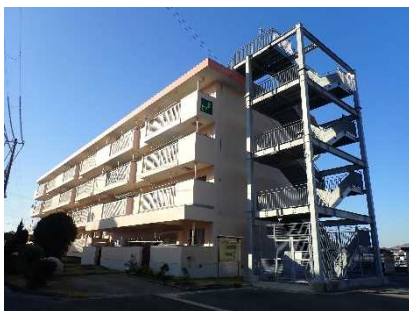
公営住宅に津波避難階段を設置
