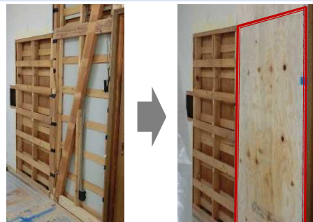
住宅耐震化（構造用合板の設置）
