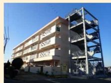
避難階段の増設（県営住宅）
