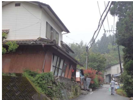
熊本地震の被災家屋（西原村）
