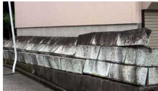
出典 (一財) 消防科学総合センター
