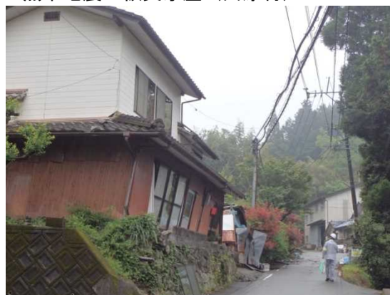
熊本地震の被災家屋（西原村）
