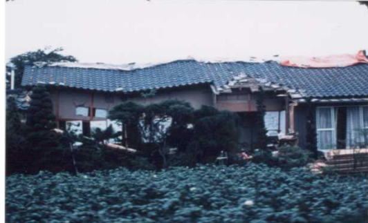
出典 被災建築物応急危険度判定マニュアル
