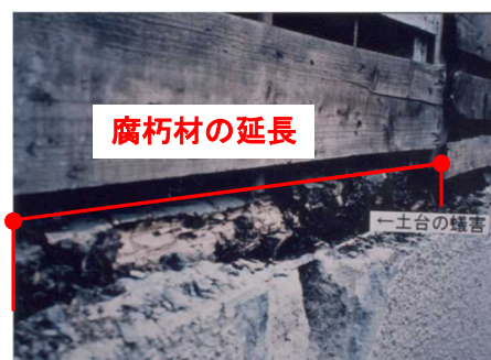
出典 被災建築物応急危険度判定マニュアル
