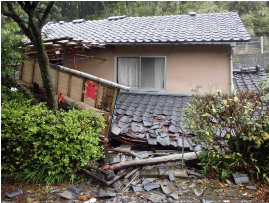
熊本地震の被災家屋（西原村）
