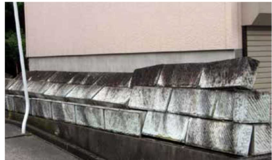
出典 (一財) 消防科学総合センター
