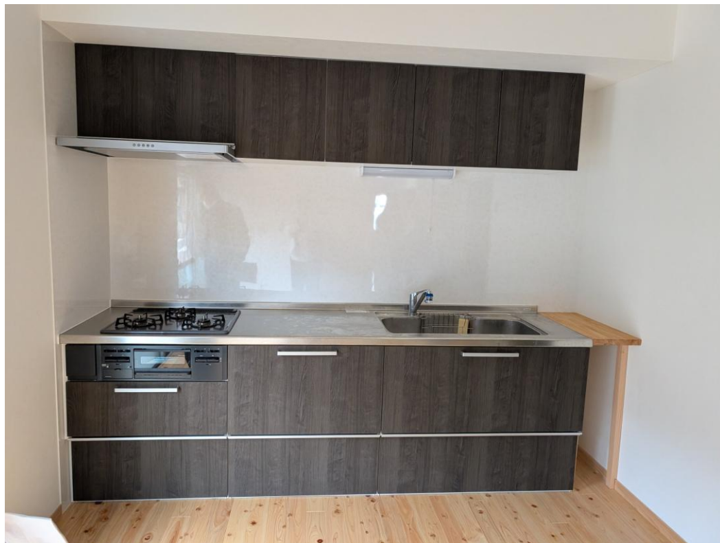
建築設備取替後
