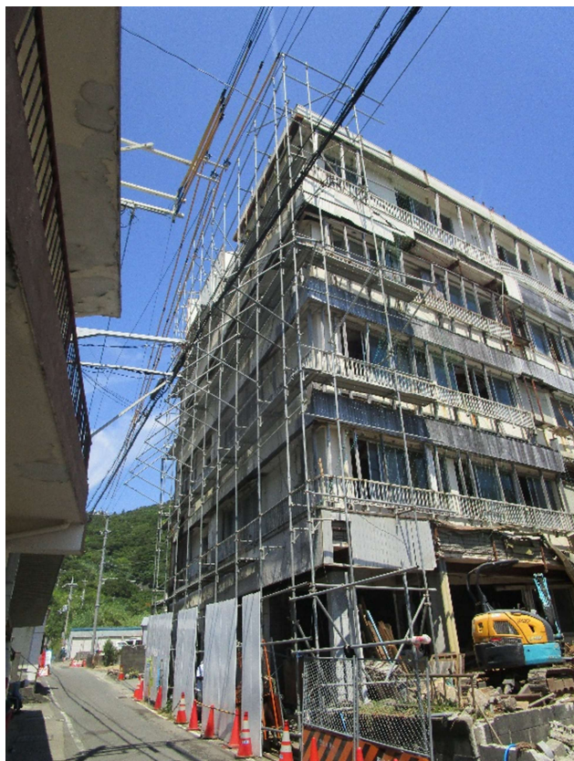
内部撤去、仮囲い設置（令和6年8月2日）
