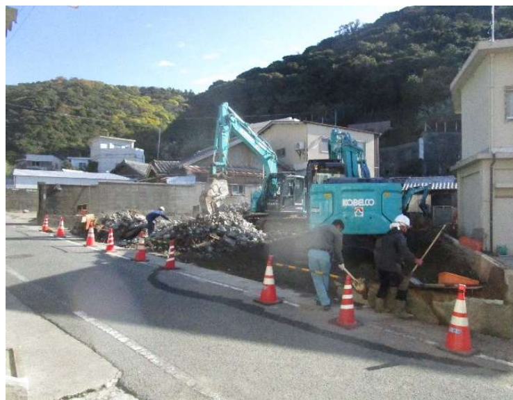
基礎解体（令和6年12月2日）
