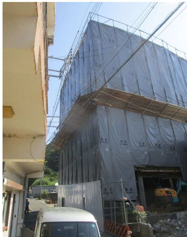
仮囲い設置完了（令和6年9月5日）
