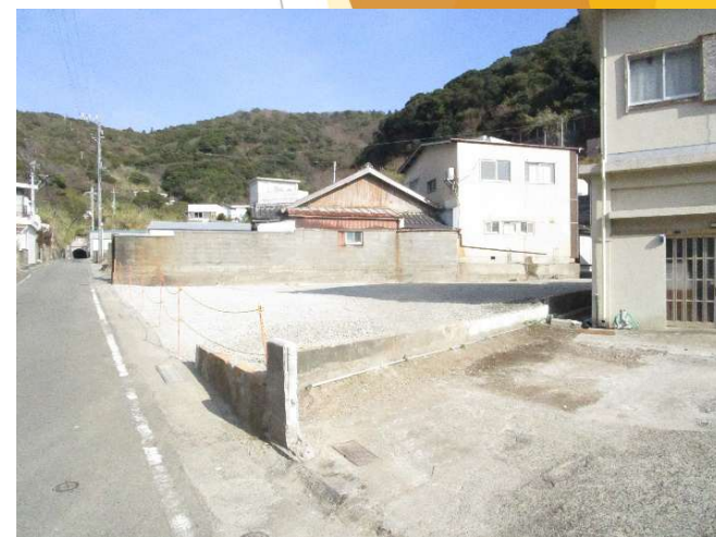
完了（令和6年12月16日）
