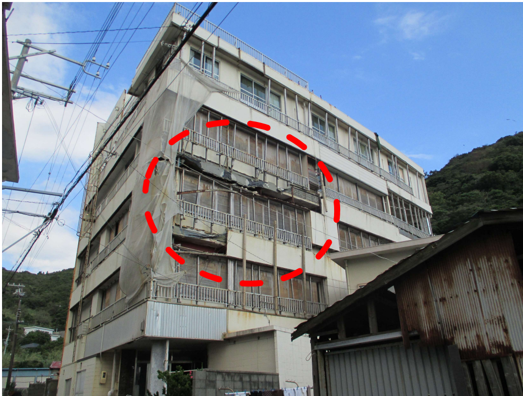
3階南側・東側外壁落下（平成26年10月）
