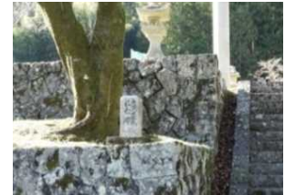
写真-5 下阿田木神社階段横にある昭和28年水害水位標。
