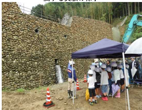
写真-5 砂防えん堤工事現場の現地見学の様子
