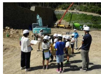
砂防工事現場の見学
