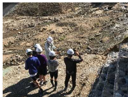
砂防えん堤現場内の地層観察
