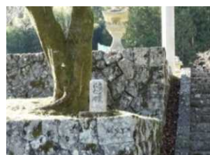
写真-3 下阿田木神社階段横にある昭和28年水害水位標。
