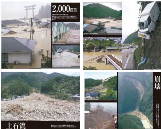
図-1 紀伊半島大水害の発生状況
