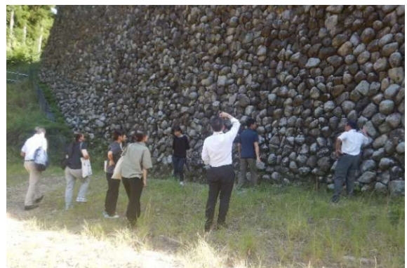
鳴子谷川砂防えん堤見学
