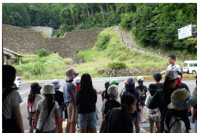
鳴子谷川砂防えん堤説明
