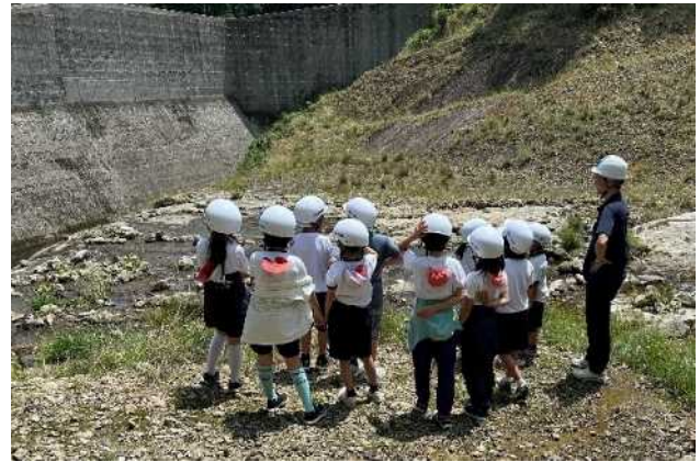
鳴子谷川砂防えん堤現地見学
