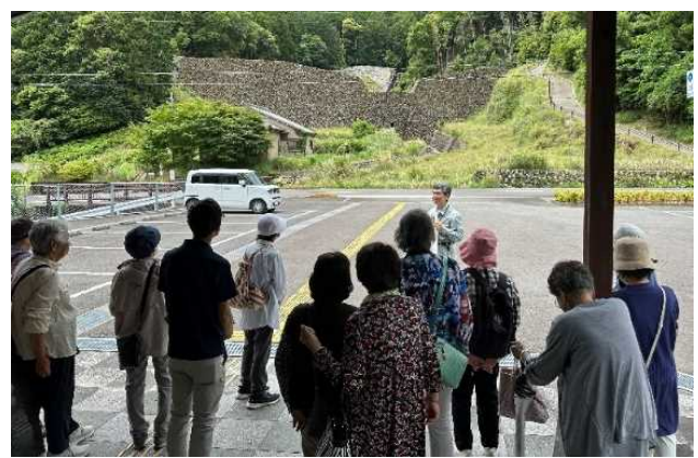
鳴子谷川砂防えん堤の説明
