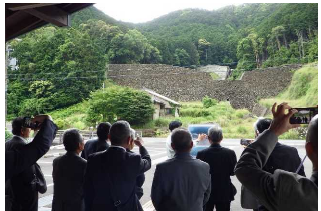
鳴子谷川砂防えん堤の説明
