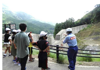
砂防工事現場の見学
