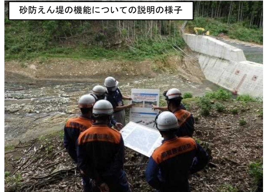
流路工などの今後の工事内容についての説明の様子
