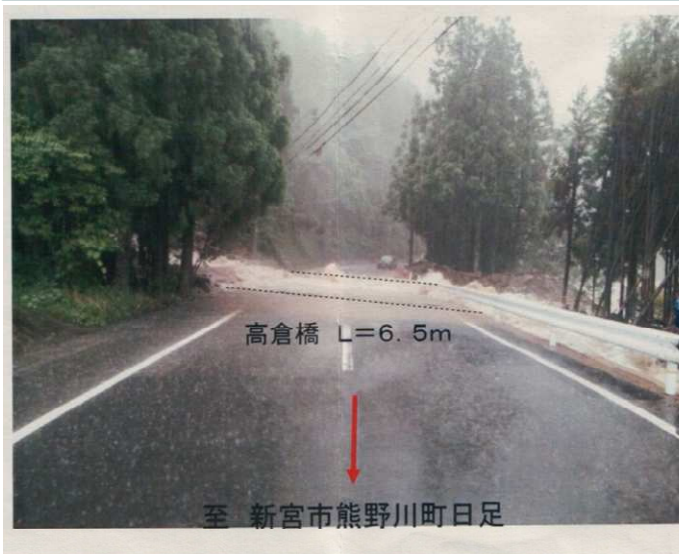
新宮市熊野川町赤木における事例
