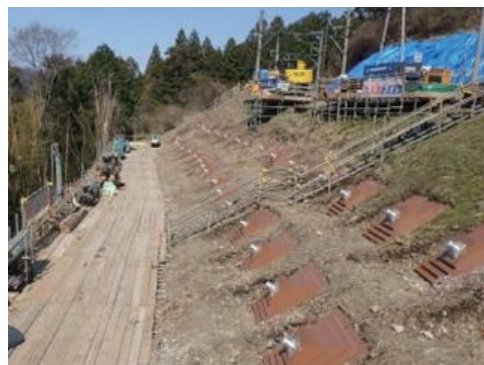
アンカー工（上古沢地区：九度山町上古沢）
