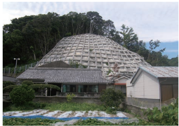
法枠工（小泊2地区：すさみ町周参見）
