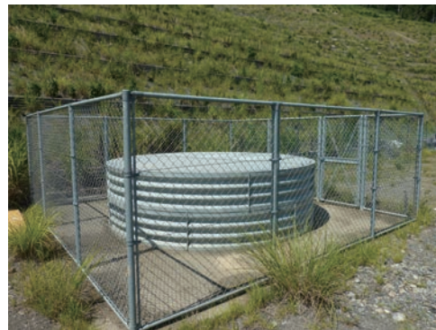
集水井工（本宮地区：田辺市本宮町本宮）
