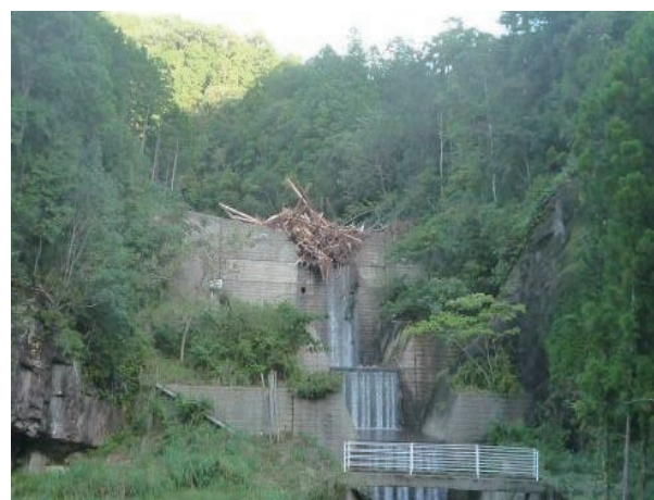
大休場谷川（新宮市熊野川町上長井） 土砂及び流木捕捉の事例（H23年9月台風12号）
