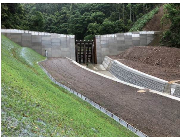
露谷川（日高川町皆瀬）透過型えん堤
