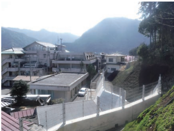
擁壁工（日足2地区：新宮市熊野川町日足）
