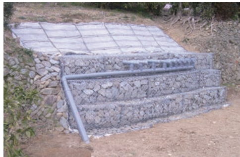
横ボーリング工（上六川地区：有田川町上六川）
