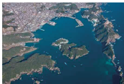
地方港湾（避難港） 勝浦港
