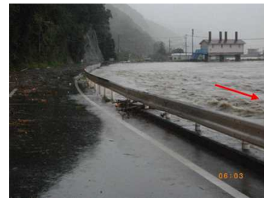
平成 23 年 9 月洪水の被害状況 (白浜町田野井地区)
