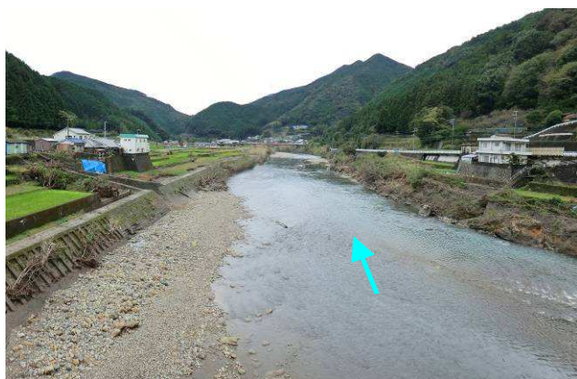
原日浦橋 (40.1k 付近) から下流を望む
