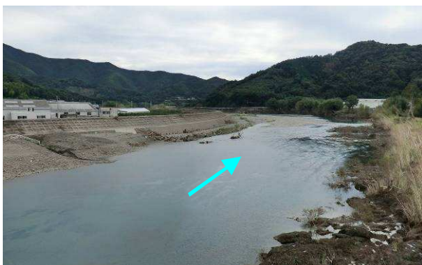
松瀬橋 (11.0k 付近) から下流を望む
