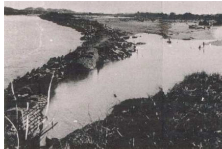
現 御坊市藤田町吉田付近 (右岸側)
