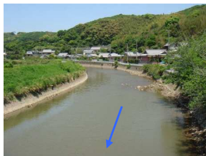
中橋上流 (4.0k 付近)
