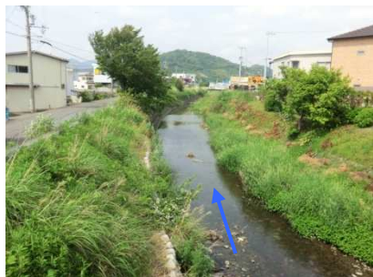
齊川 皆堰橋より下流を望む (0.9k 付近)
