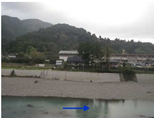
右岸(30.7k 付近)から左岸を望む
