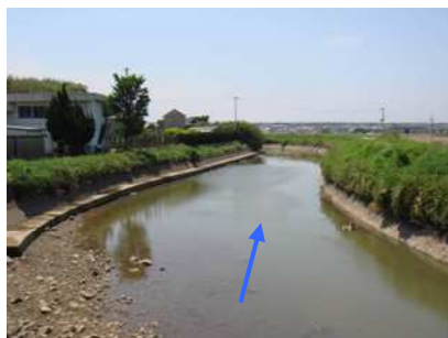
中橋下流 (4.0k 付近)
