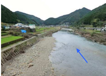
はらぶら 原目浦橋下流 (40.1k 付近)
