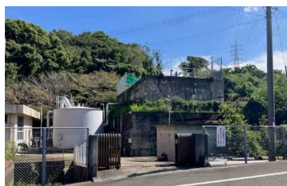
図 2-7 湯浅町横田浄水場（水道用水）
