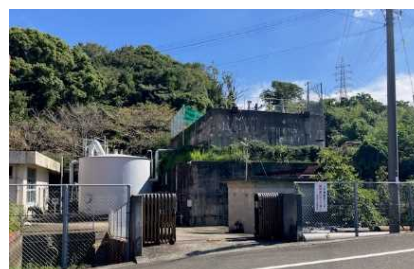
図 2-7 湯浅町横田浄水場（水道用水）
