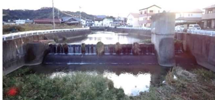
図 2-6 藪田井堰（農業用水）
