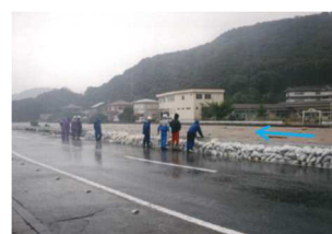
平成13年8月 望見橋より下流付近(0.8k)
