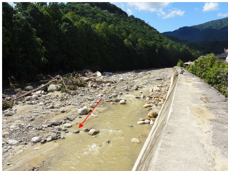
長谷川合流点上流
