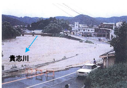
図7 国道424号冠水状況(平成13年6月)
