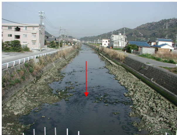
図 8 0.6k 付近（国体第三号橋から上流側を望む）
