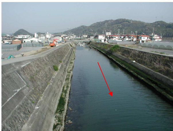
図 7 亀の川河口（0.0k 付近から上流）
