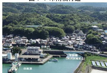
図 1-5 印南川河口付近
