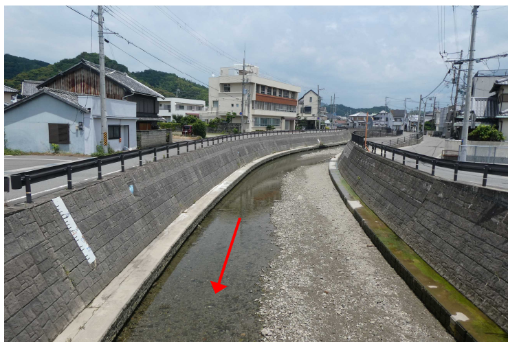
図4-6 1.2k付近（東橋から上流側を望む）
