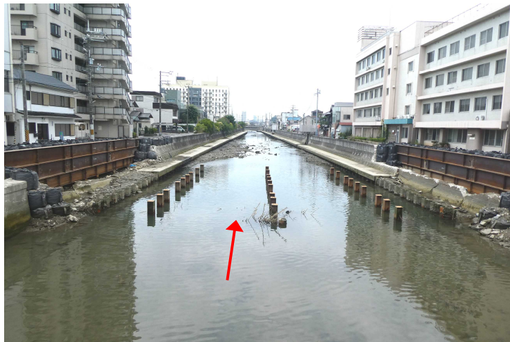
図4-4 0.6k付近（新町橋から下流側を望む）
