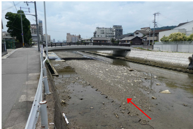
図4-5 0.9k付近（下橋付近を望む）
