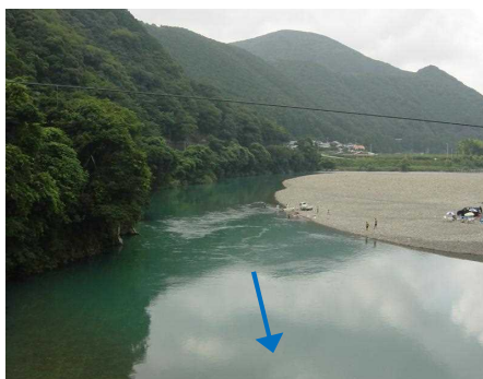
安居橋上流 (10.8k 付近)
