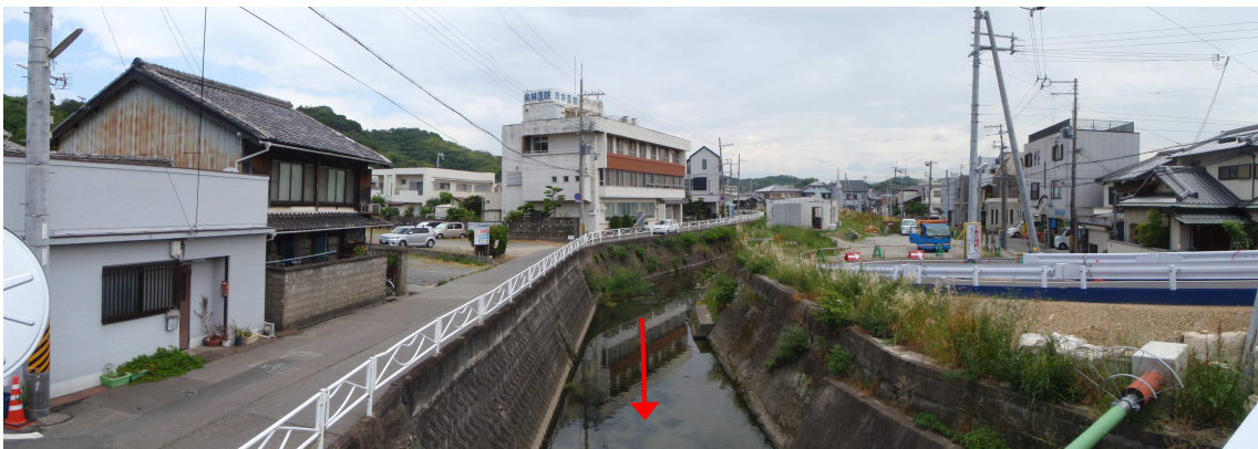
図4-6 1.2k付近（東橋から上流側を望む）
