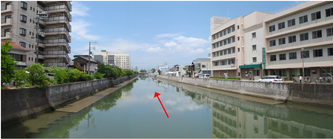
図4-4 0.6k付近（新町橋から下流側を望む）
