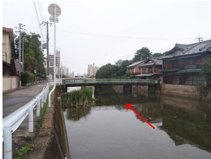
図4-5 0.9k付近（下橋付近を望む）
