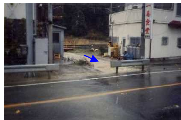
【支川逆川（国道42号交差点部）】
