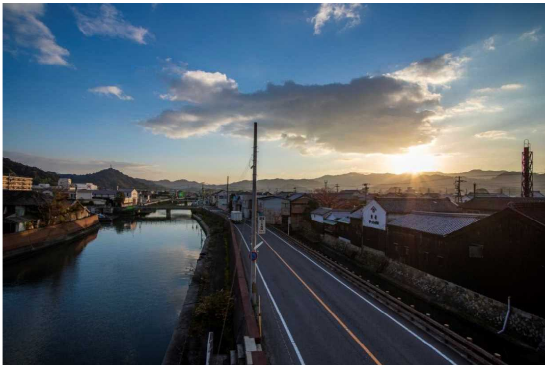
【山田川河口と大仙堀（下流側から撮影）】
