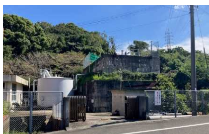
図 2-6 湯浅町横田浄水場（水道用水）
