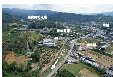
図 1-4 一之橋付近 (2.4k 付近)
