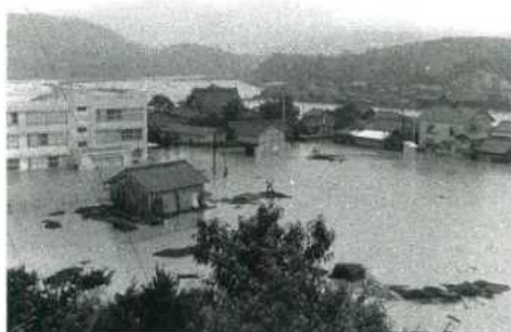
昭和37年 印南小学校付近 (0.7k 右岸付近)
