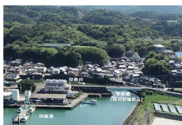
図 1-5 印南川河口付近
