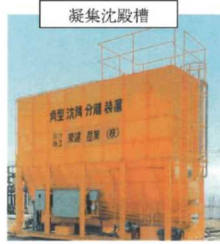
写真 濁水処理設備
