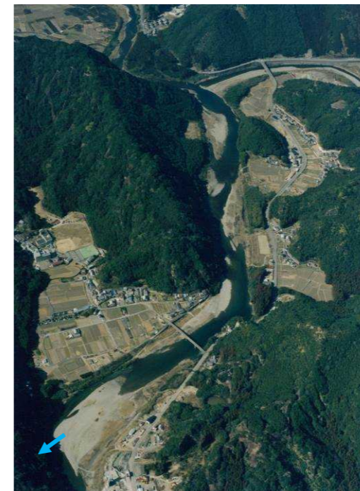
下流域（平成 13 年） 4.0k～7.0k （高瀬橋付近）
