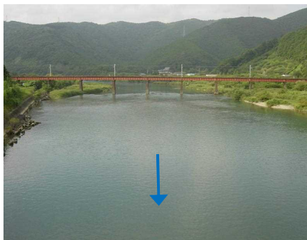
安宅橋上流 (2.4k 付近)
