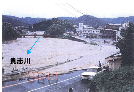
図7 国道424号冠水状況(平成13年6月)
