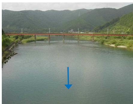
安宅橋上流 (2.4k 付近)
