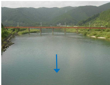
安宅橋上流 (2.4k 付近)
