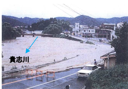
図7 国道424号冠水状況(平成13年6月)
