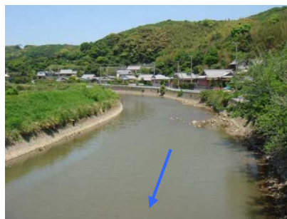
中橋上流 (4.0k 付近)
