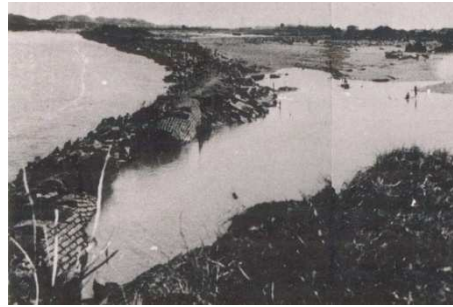
現 御坊市藤田町吉田付近 (右岸側)
