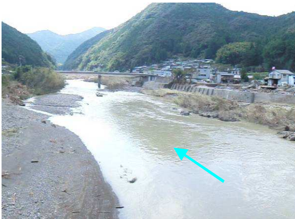
川上橋 (45.5k 付近) から下流を望む
