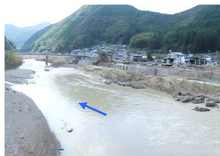
川上橋下流 (45.5k 付近)
