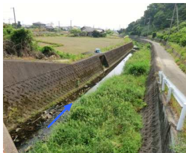
齊川 吉田橋より下流を望む (3.2k 付近)
