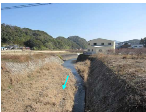
千曳橋 (0.65k 付近) から上流を望む
