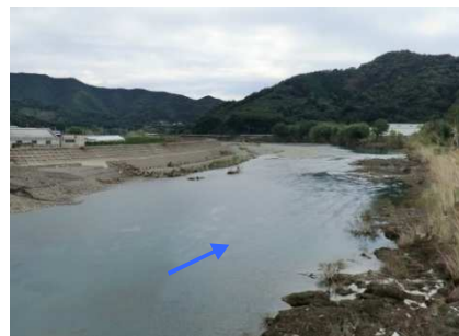
まつの 松瀬橋下流 (11.0k 付近)
