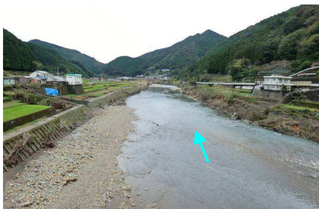
原日浦橋 (40.1k 付近) から下流を望む
