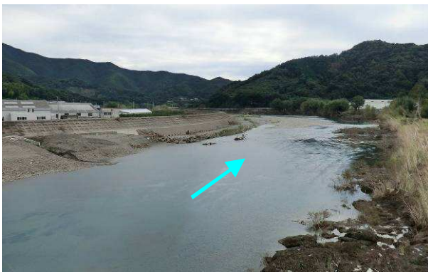
松瀬橋 (11.0k 付近) から下流を望む
