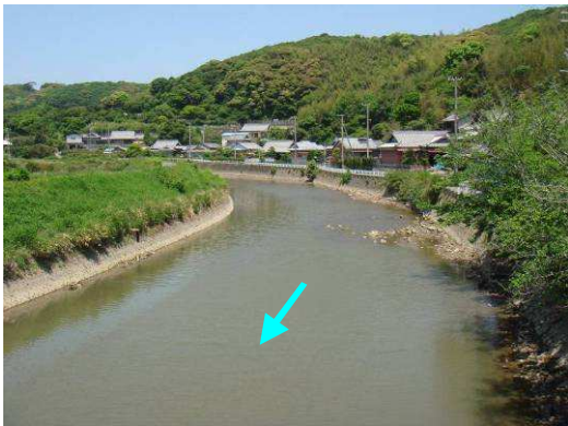
中橋 (4.0k 付近) から上流を望む
